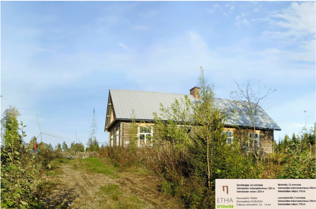
Kuva 10.34 Havainnekuva Lahnasen Ylätalolta. Kuva vastaa 50 mm objektiivia. Etäisyys lähimpään voimalaan noin 1,6 km. Tässä kuvassa on jo huomioitu voimalan 31 muuttunut sijainti, joten sitä ei merkitä erikseen, kuten muista kuvauspisteistä laadituissa havainnekuville.
