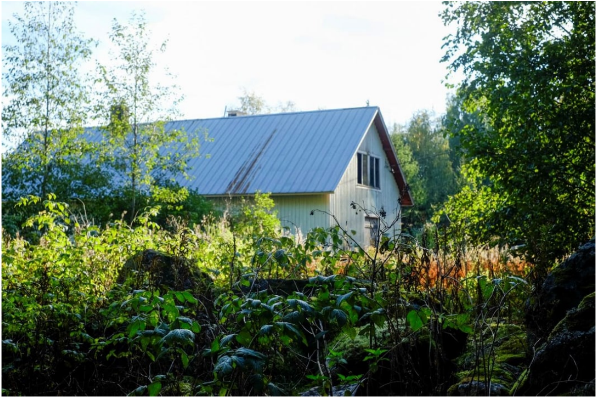
Kuva 4.9 Petäjämäen päärakennus. Pihapiiri on kasvamassa kovaa vauhtia umpeen.
