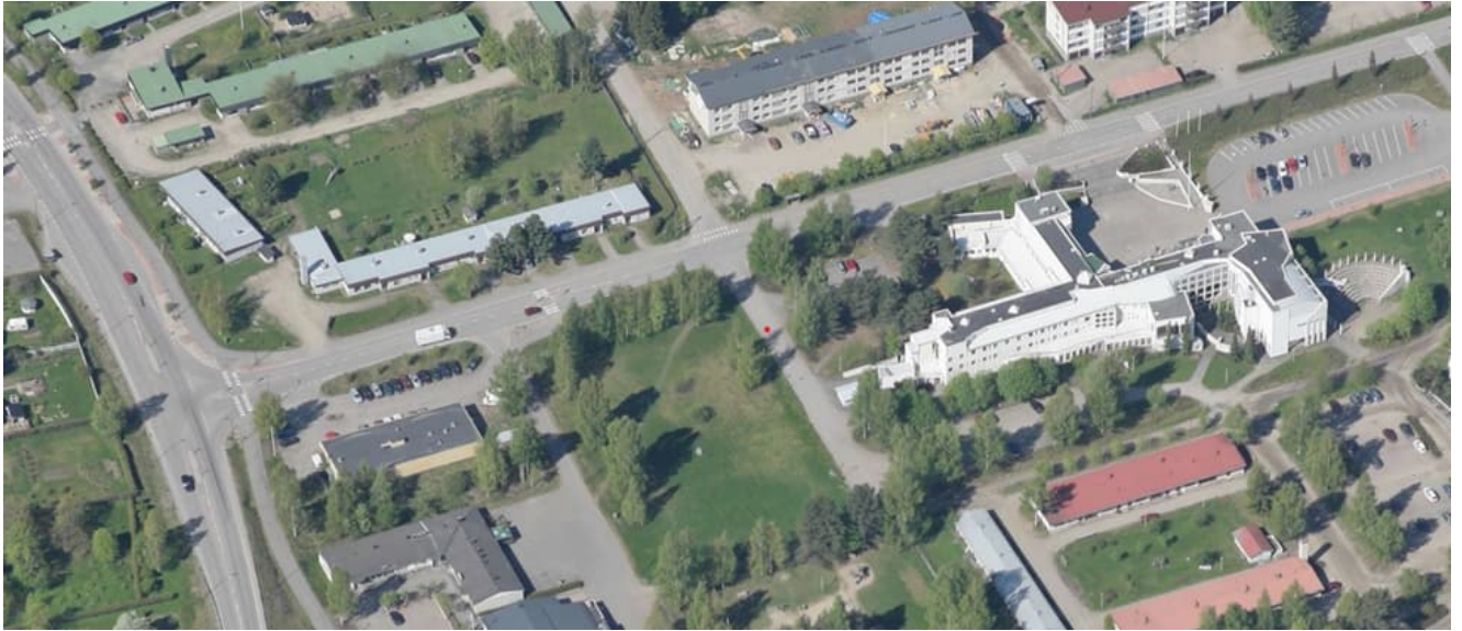
Kuva 3: Yleiskuva suunnittelualueesta. Oikealla sijaitseva valkoinen rakennus Kanttila. (2012)
