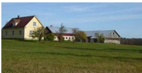
KUVA 31. Rustholli. Maakunnallisesti arvokasta rakennettua kulttuuriympäristöä.
