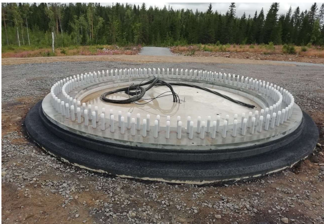
KUVA 40. Toteutettu esimerkki perustuksen maanpäällisestä osasta
