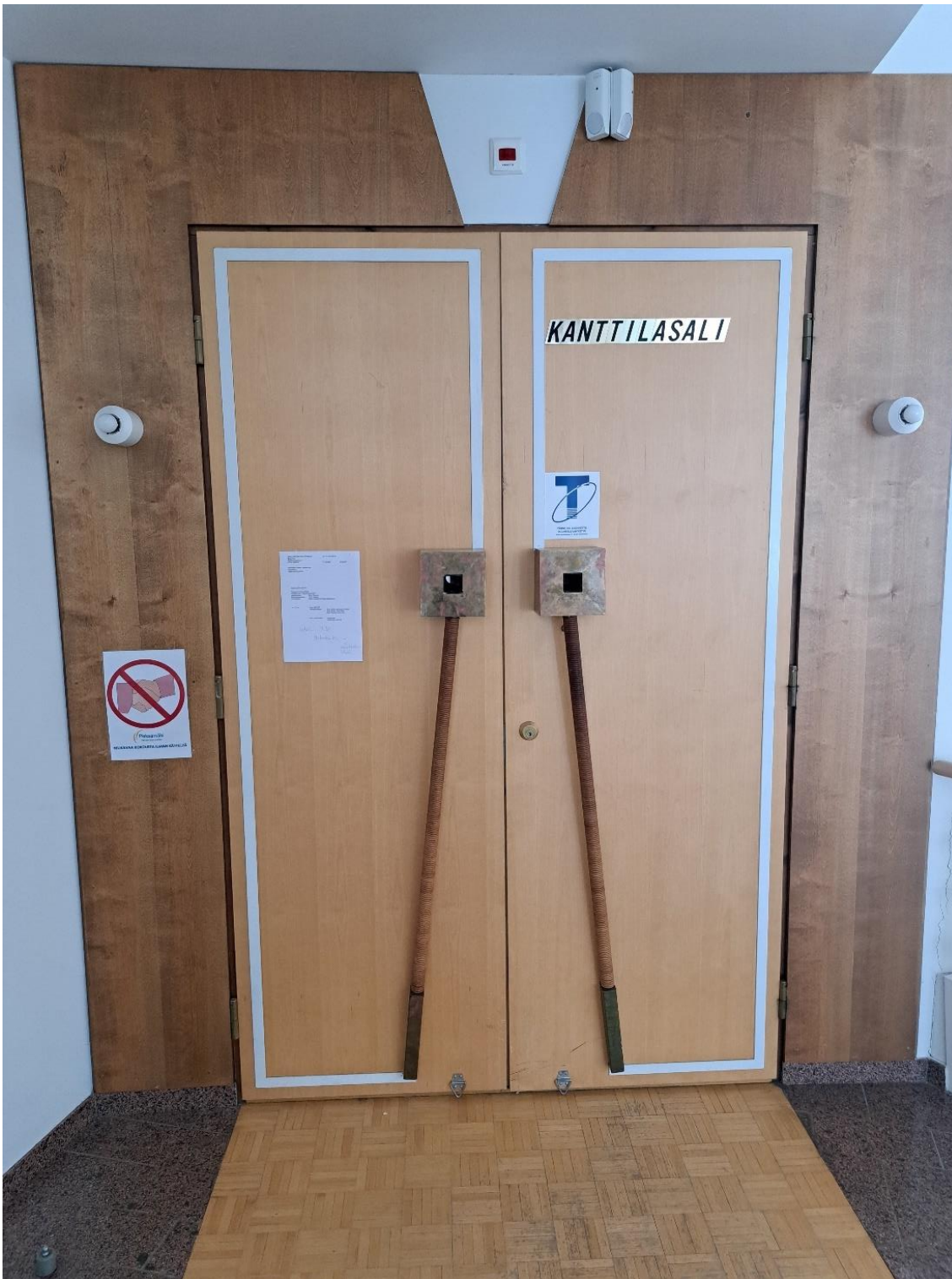
Kuva 39 Vuoden 2024 kuva (Reponen Heikki, Pieksämäen kaupunki) Kanttilasalin ovista. Ovissa ei ole kuvien perusteella havaittavissa muutoksia vuoden 2018 inventoinnin tilanteeseen.
