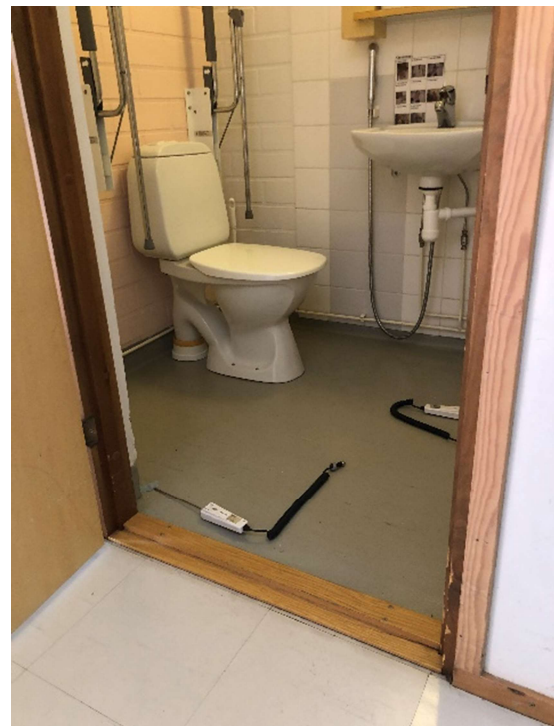
Kuva 18 WC lattia muovimattoa, seinät laatoitettuja
