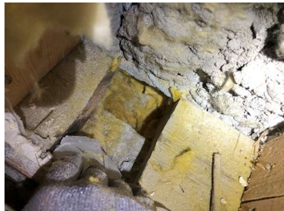
Kuva 39 RA17, sokkelin lämmöneristeenä on mineraalivilla
