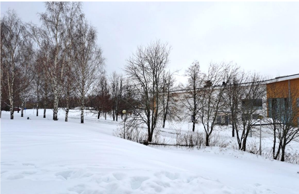
Kuva 63 Kuva Kanttilasta, 2024 (Reponen Heikki, Pieksämäen kaupunki). Amfiteatteri ja sen betonirakenteet on purettu Kanttilan luoteispäädystä. Kuvan oikeassa reunassa taustalla näkyy vuonna 2021 valmistunut Maaselän päiväkotikoulu.
