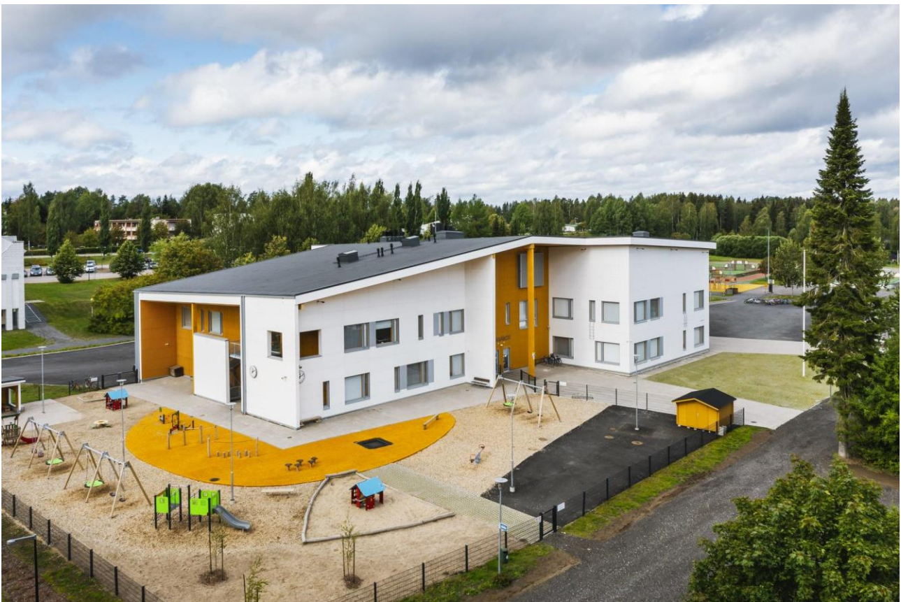
Kuva 47 Vuonna 2021 valmistunut Maaselän päiväkoti kuvattuna idästä. Kuvan vasemmassa reunassa Kanttilan pohjoisnurkka. Koulun toteuttaja on Lehto Tilat Oy. (Kuvälähde: Lehto )
