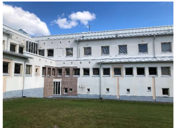
Kuva 8 Yleiskuvaa julkisivusta, julkisivussa paikoin graani-tilaattaa
