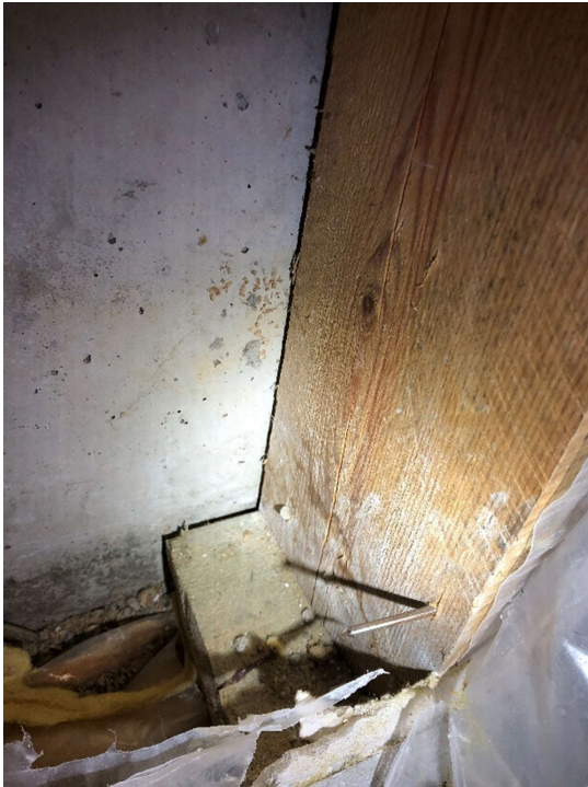
Kuva 29 RA8, puurunko ja lämmöneriste kiinni betonissa
