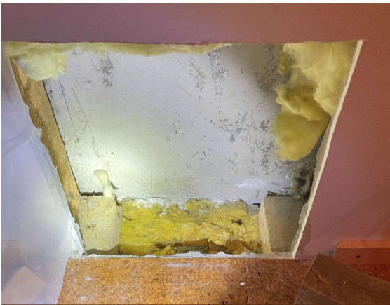
Kuva 27 RA1, seinä mineraalivillaeristeinen, sokkelihalkaisuna mineraalivillaa
