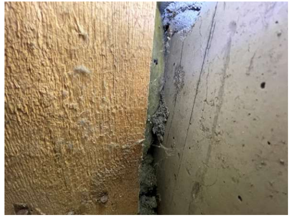
Kuva 28 RA1, puurungossa tuuletusrako, seinän lämmöneriste kiinni betonissa
