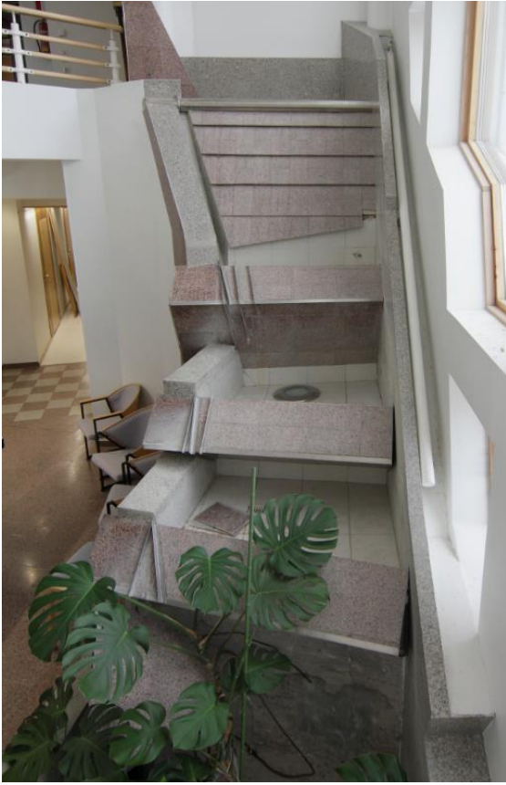
Kuva 52 Kuva vuoden 2018 rakennetun kulttuuriympäristön selvityksestä (Kervinen Minttu, FCG). Pääaulasta kansalaisopiston tiloihin laskevan portaikon viereinen vesiaihe. Vesiputous on ollut pitkään kuivillaan, koska vettä roiskui lattiallekin.
