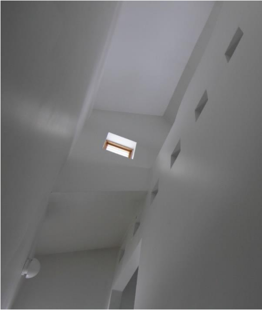
Kuva 34 Kuva vuoden 2018 rakennetun kulttuuriympäristön selvityksestä (Kervinen Minttu, FCG). Eteläisen virastosiiven eteläpääty. Päätyä korostavat harjakattoiset rakennusmassat, jotka hahmottuvat sisältäkin.
