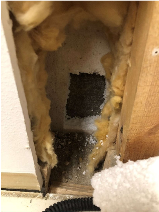
Kuva 21 RA4, seinärakenne puurakenteinen, betonia vasten EPS
