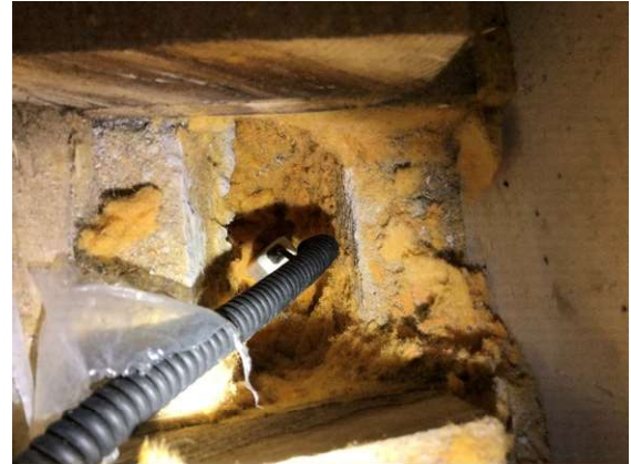
Kuva 41 RA18, sokkelihalkaisuna mineraalivilla
