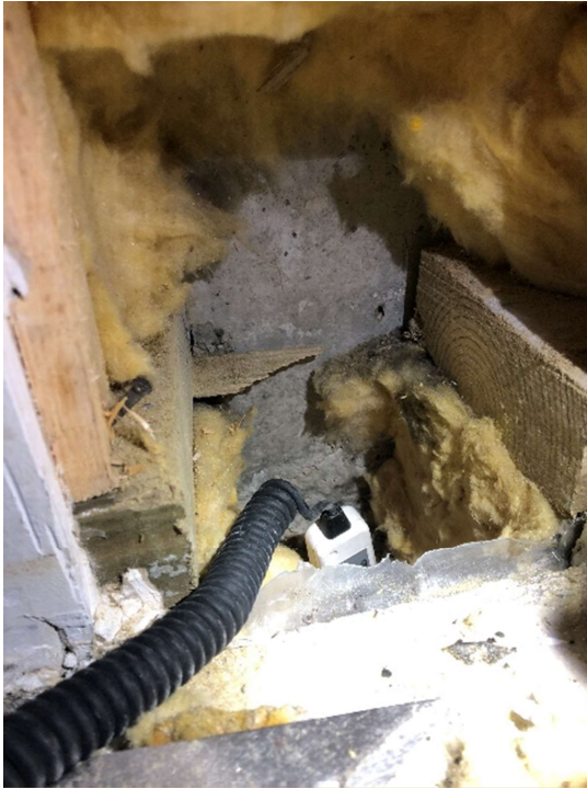
Kuva 24 RA6, sokkelihalkaisuna mineraalivillaa, syvyys noin 350 mm, seinän lämmöneriste betonia vasten
