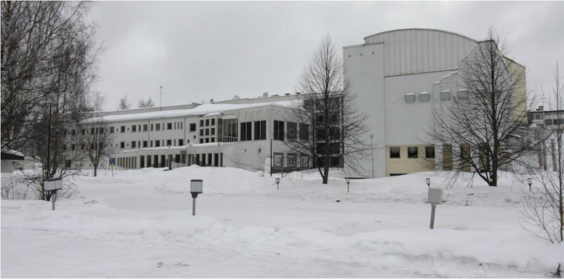
Kuva 50 Kuva vuoden 2018 rakennetun kulttuuriympäristön selvityksestä (Kervinen Minttu, FCG). Kanttilan julkisivu koilliseen. Koillisjulkisivulta on sisäänkäynnit alun perin kansalaisopiston tiloina toimineeseen alakerrokseen.
