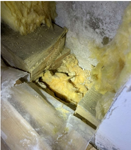
Kuva 31 RA9, alasidepuun alla sokkelihalkaisuna mineraalivillaa
