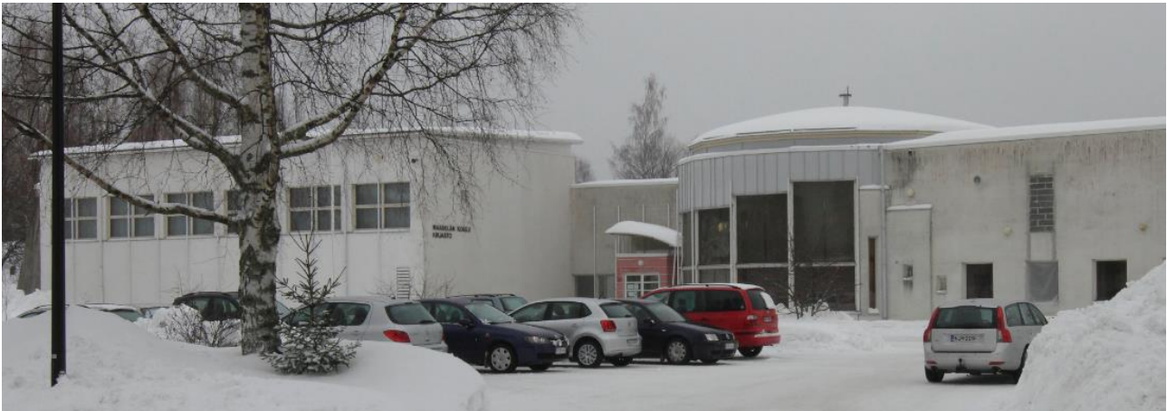
Kuva 46 Vuonna 2019 purettu Maaselän koulu. Vasemmalla liikuntahalli, keskellä pääsisäänkäynti ja oikealla ruokala. Kuvassa koulun julkisivu kaakkoon (Kervinen FCG, 2018).
