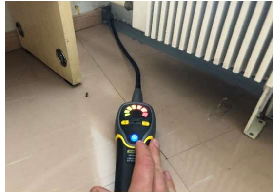
Kuva 43 Merkittävää ilmavuotoa tilan 0050 alapohjan ja ulkoseinän liitoksesta
