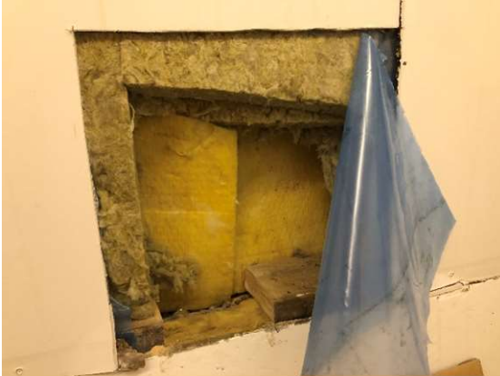
Kuva 32 RA10, sisäpinnassa höyrynsulkumuovi, takana tuulensuojana kova villa
