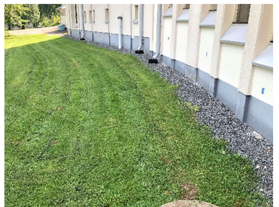
Kuva 4 Nurmipintaisten alueiden seinustalla sepelikaista
