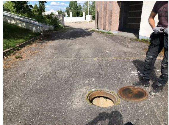
Kuva 2 Pysäköintialue ja osa kulkuväylistä asfaltoitu
