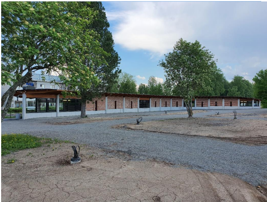
Kuva: Alueella sijaitseva asematunneli.
