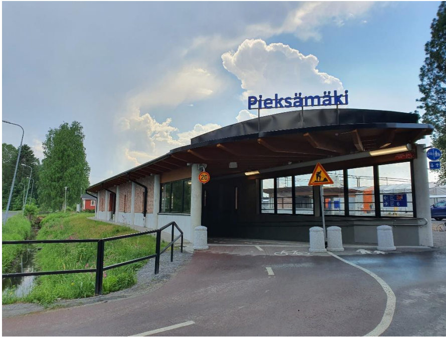
Kuva: Alueella sijaitseva asematunneli.
