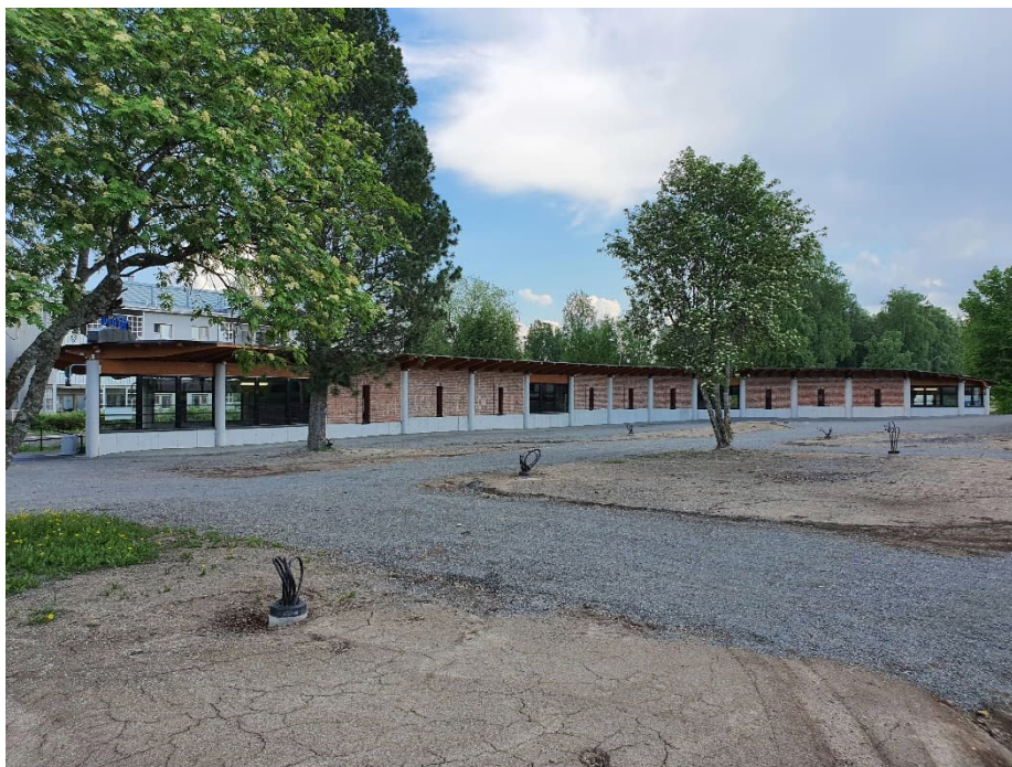
Kuva: Alueella sijaitseva asematunneli.
